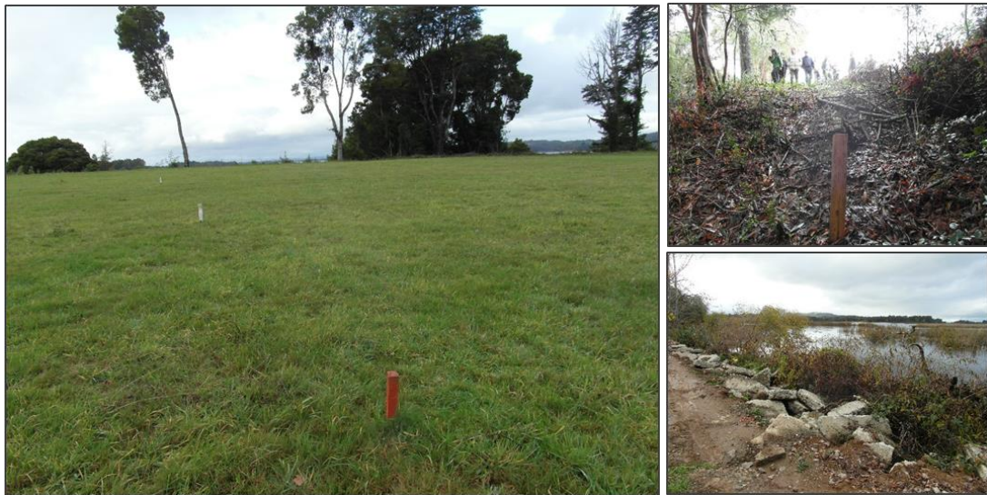
Figura 2: Fotografías del Predio. 1: Zona delimitada con estacas. 2: Zona con despeje vegetal. 3: Zona con mejoras en las vías de acceso (terraplén).
