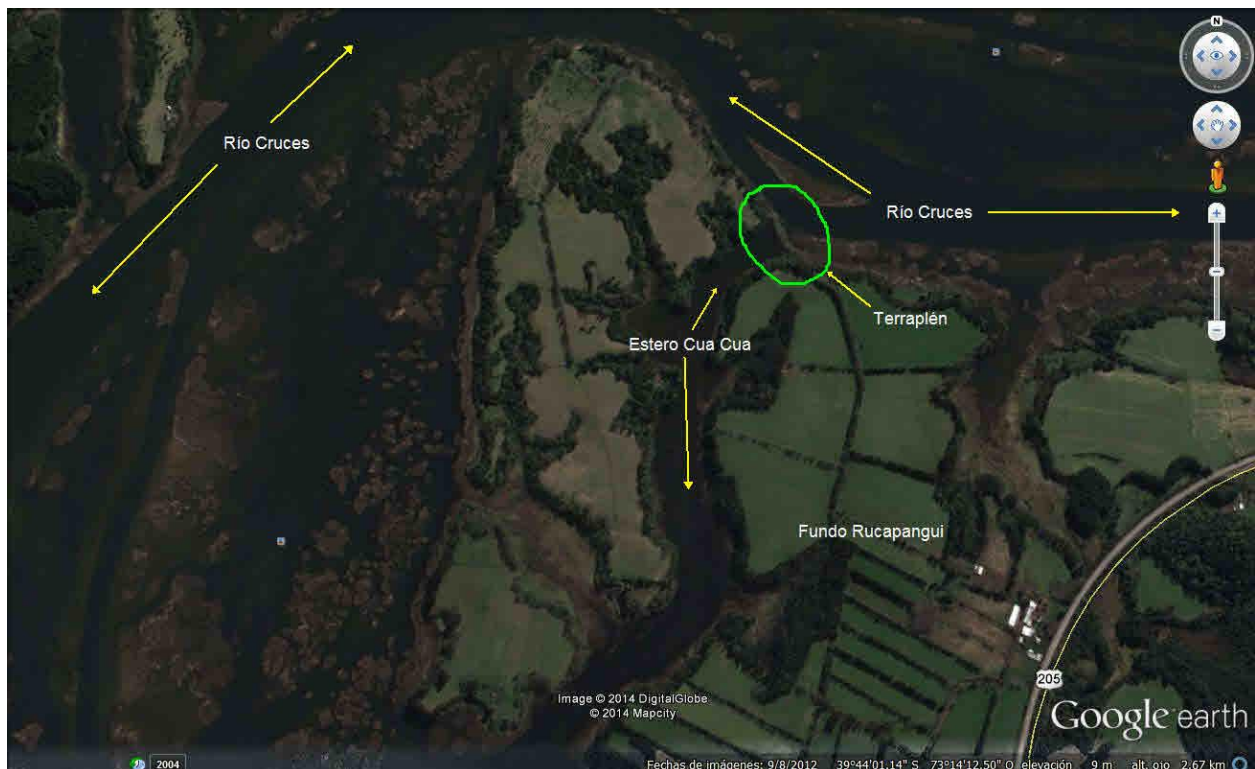
Figura 9. Vista aérea del Predio y terraplén. Fuente: Google Earth.
