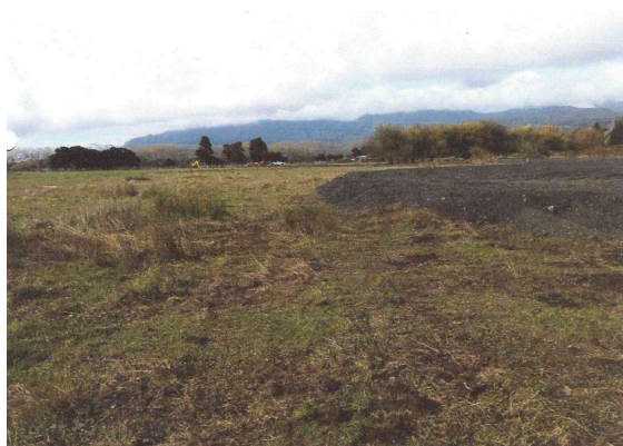
Figura N°7: Fotografía adjunta a Informe construcción proyecto Bahía Pucón, de inspección realizada el 3 de mayo 2018, donde se observa movimiento de tierra. Fuente: Informe construcción Proyecto Bahía Pucón (fs. 97)
