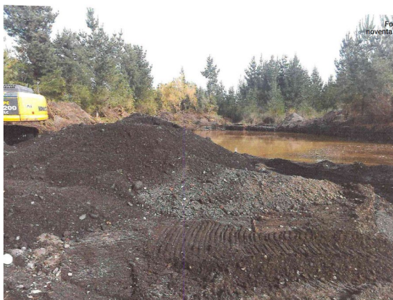
Figura N°4: Fotografía adjunta a Informe construcción proyecto Bahía Pucón, de inspección realizada el 3 de mayo 2018, donde se observa movimiento de tierra y presencia de maquinaria pesada. Fuente: Informe construcción Proyecto Bahía Pucón (fs. 96)
