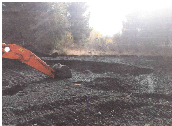
Figura N°5: Fotografía adjunta a Informe construcción proyecto Bahía Pucón, de inspección realizada el 3 de mayo 2018, donde se observa movimiento de tierra y presencia de maquinaria pesada. Fuente: Informe construcción Proyecto Bahía Pucón (fs. 96)
