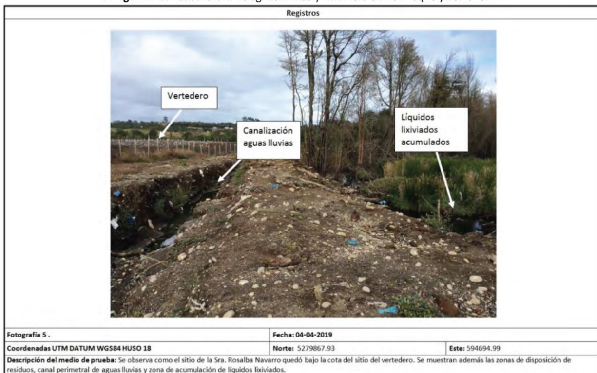
Imagen N° 8: Canalización de aguas lluvias y trinchera entre bosque y vertedero
