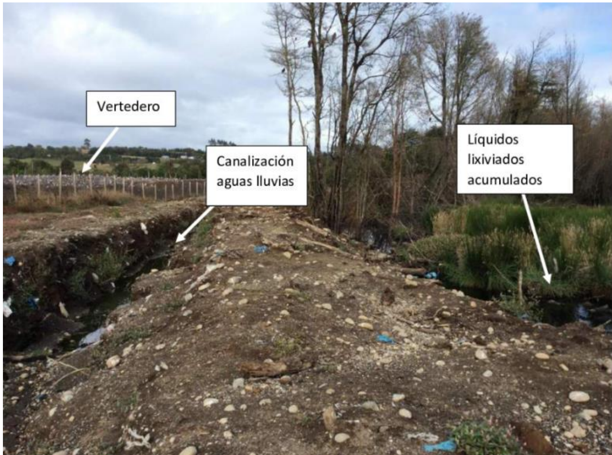
Figura N° 16: Sector en donde se observa que el terreno de Sra Rosalba Navarro quedó inundado. Fuente: DFZ-2019-489-X-RCA-IA de abril de 2019 (Fs. 4406)
