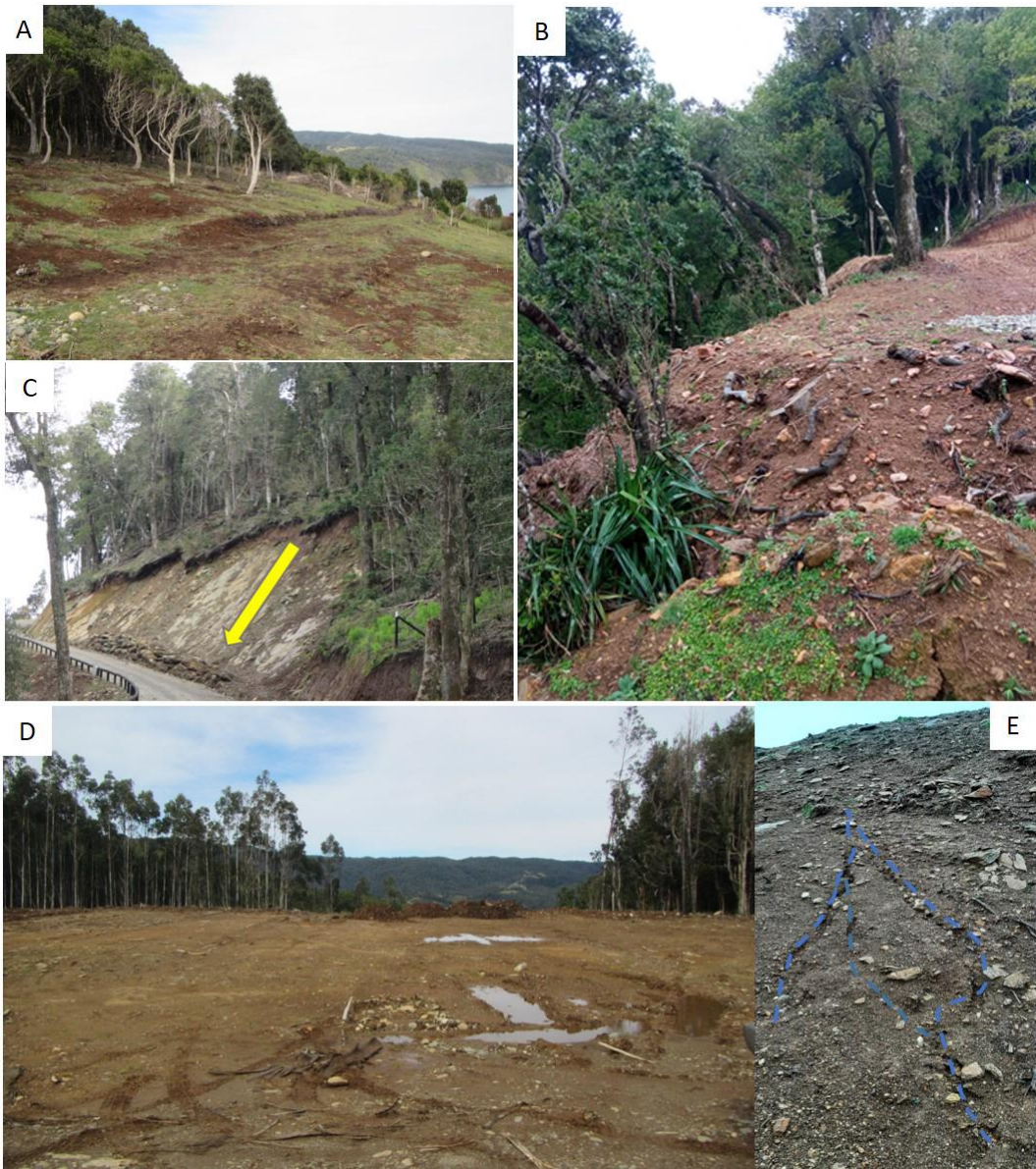
Figura 35. Piedra Hueca (Pilolcura). A. Raleo de sotobosque en sector de Mirador. B. Detalle del relleno instalado ladera abajo del terraplén junto a zona recreativa. C. Remoción en masa activa en camino interior, los planos de foliación de la roca actúan como plano de deslizamiento para la cubierta de suelo y vegetación inestable. D. Acopio de material excavado para caminos en terreno de ex plantación forestal. Cubierta detrítica limo-arcillosa impide infiltración de agua. E. Las laderas de acopio presentan erosión incipiente por escorrentía superficial. Fuente: Informe Técnico de SERNAGEOMIN, 2021 (fs. 468).
