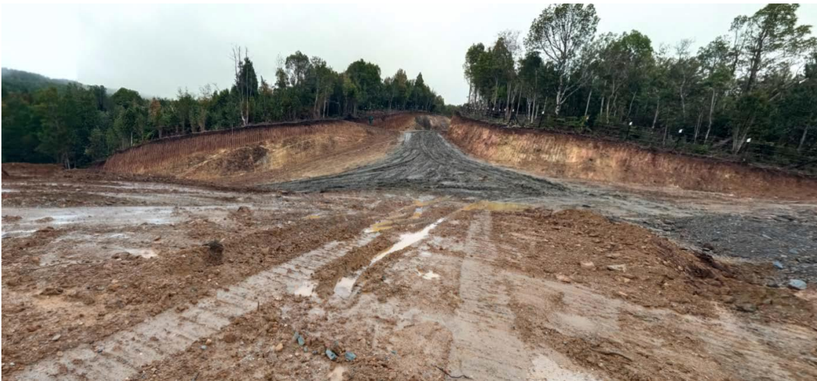
Figura 30. El Canelal. Camino interior de acceso a parcelas, desde el sur hacia la zona de excavación, fotografía tomada desde el terraplén (23 de junio de 2021). Fuente: Informe Técnico de SERNAGEOMIN (fs. 471).
