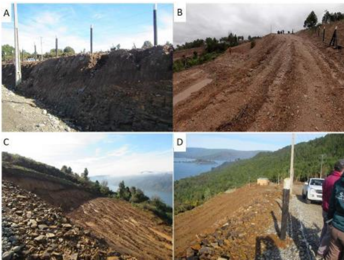
Figura 18. A y B: Intervención de la superficie del terreno, excavación de caminos y remoción total de la cubierta vegetal y los horizontes superiores de
