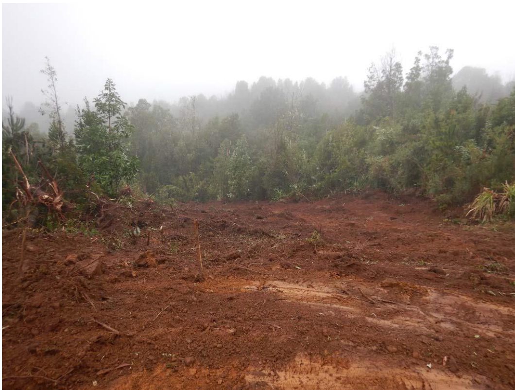
Figura 10. Extracción de capa vegetal y despeje de zonas para el acopio de áridos, 12 de agosto de 2020. Fuente: SMA, "Informe Técnico de Fiscalización Ambiental DFZ-2020-3202-XIV-SRCA" (fs. 131).
