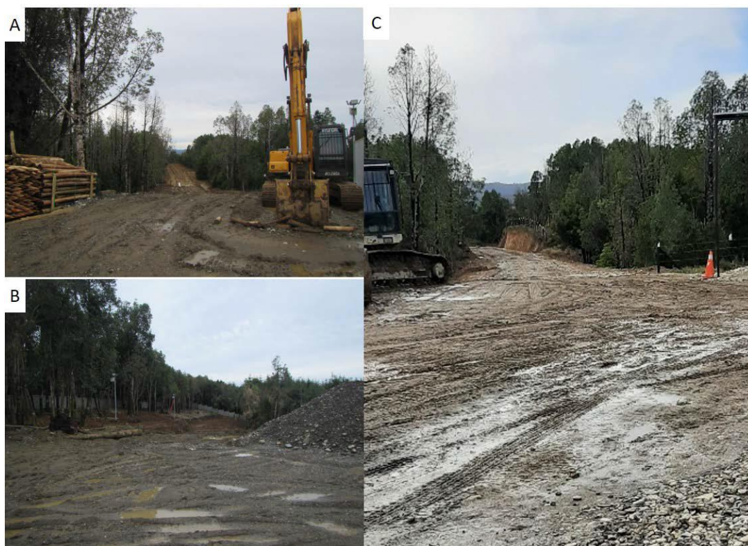
Figura 28. El Canelal. A y B. Sector de instalación de faena ubicada en el acceso al loteo (fotografías de 4 de septiembre de 2020). A. Se cortó una franja de bosque en torno al cerco perimetral, para la instalación de cámaras de vigilancia. B. Vista hacia el norte, hacia el camino interior de acceso a los lotes, cuyo trazado se observa al nivel del suelo. C. Fotografía tomada aproximadamente en la misma dirección que B (23 de junio de 2021). El camino interior presenta taludes que superan los 3 m de altura con pendientes mayores a 45°. Fuente: Informe Técnico de SERNAGEOMIN (fs. 470).
