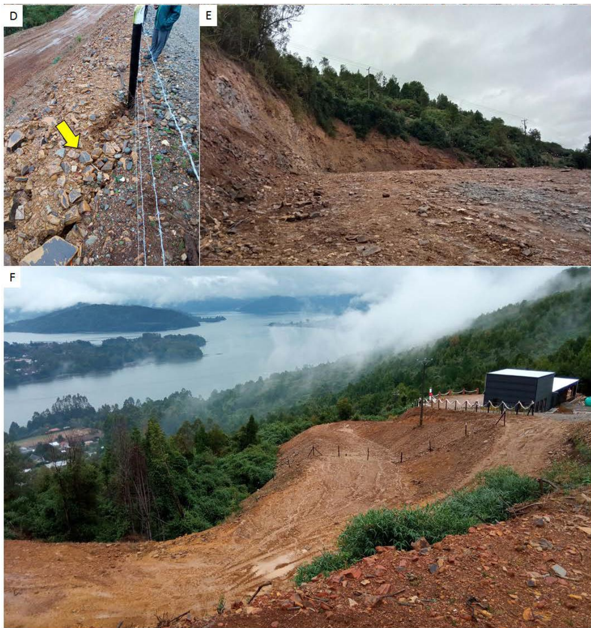
Figura 19. D: Grieta de tensión en el borde de camino interior. E: Talud de aproximadamente 6 m de altura y terraplén. F: Terraplenes construidos en el sector de escarpe de remoción en masa. Se observa población al pie de la ladera. Fuente: SERNAGEOMIN (fs. 476).
