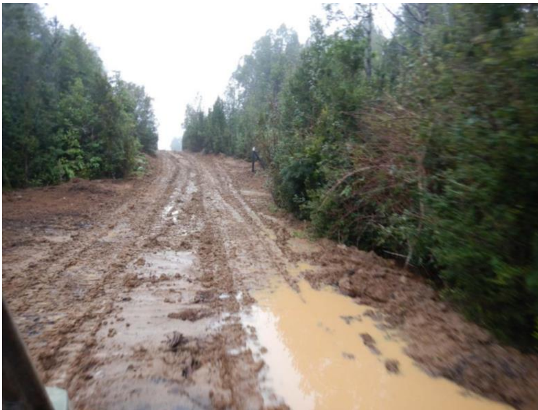
Figura 9. Obras para habilitar caminos de un ancho aproximado de 6 m en el Proyecto Predio Canelales-Los Pellines, 12 de agosto de 2020. Fuente: SMA, "Informe Técnico de Fiscalización Ambiental DFZ-2020-3202-XIV-SRCA" (fs. 131).
