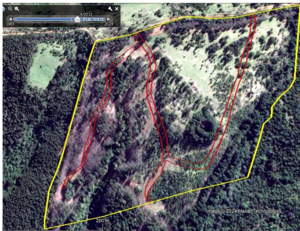
Figura 27. Superficies intervenidas en comparación con el estado del sector, previo a la construcción de los caminos, según una imagen de 2012. Fuente: Informe “Evaluación de Impactos Hidrogeología Predio Cutipay II” Mayo 2024, AMEST (fs. 10055).
